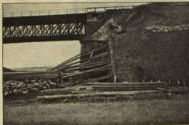
Most přes Červený potok u Stačova u Zdic. Obrázky znázorňují zahájení prací pro rozšíření opěr. Vlevo jest viděti, jak byl zachycen zemní tlak hráze po odbourání původního křídla. Vpravo je patrně částečně vybuděné nové křídlo. Je zajímavé, že tento viadukt nebyl původně železný, nýbrž klenutý o 3 obloucích. Při povodni v r. 1872 se však zřítíl a byl nahrazen pak železnou konstrukcí a dodatečně zesílenou konstrukcí třetím hlavním nosníkem, umístěným v ose mostu, kterou jest ještě na obrazech viděti. Její výšlost jest 36,3 m. Při stavbě druhé koleje byl nahrazen dvěma mosty vedle sebe, každý o váze 101 tuny.
