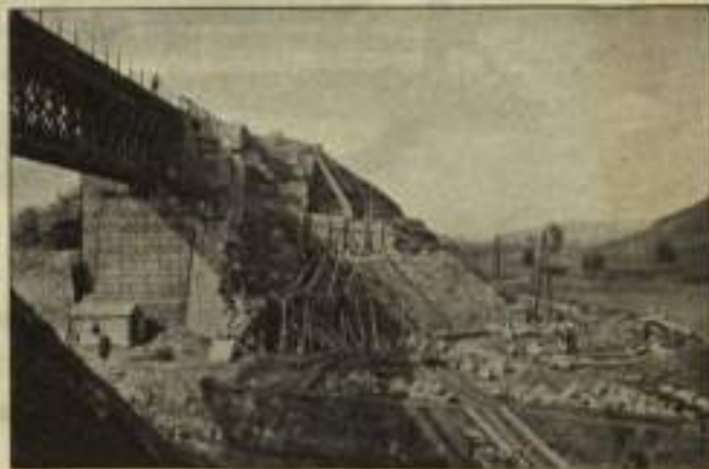
Most přes Červený potok u Stačova u Zdic. Obrázky znázorňují zahájení prací pro rozšíření opěr. Vlevo jest viděti, jak byl zachycen zemní tlak hráze po odbourání původního křídla. Vpravo je patrně částečně vybuděné nové křídlo. Je zajímavé, že tento viadukt nebyl původně železný, nýbrž klenutý o 3 obloucích. Při povodni v r. 1872 se však zřítíl a byl nahrazen pak železnou konstrukcí a dodatečně zesílenou konstrukcí třetím hlavním nosníkem, umístěným v ose mostu, kterou jest ještě na obrazech viděti. Její výšlost jest 36,3 m. Při stavbě druhé koleje byl nahrazen dvěma mosty vedle sebe, každý o váze 101 tuny.
